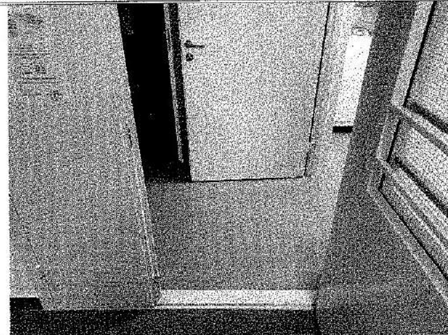
Фото №22 – Пути движения внутри здания (двери).
