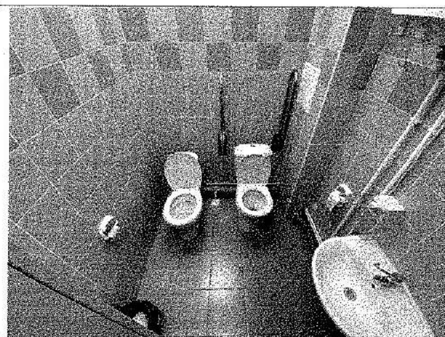
Фото №38 – Санитарно-гигиенические помещения (оборудованный для доступа МГН)
