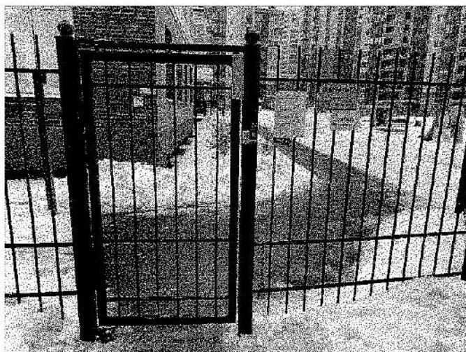
Фото №1 – Вход на прилегающую территорию.
