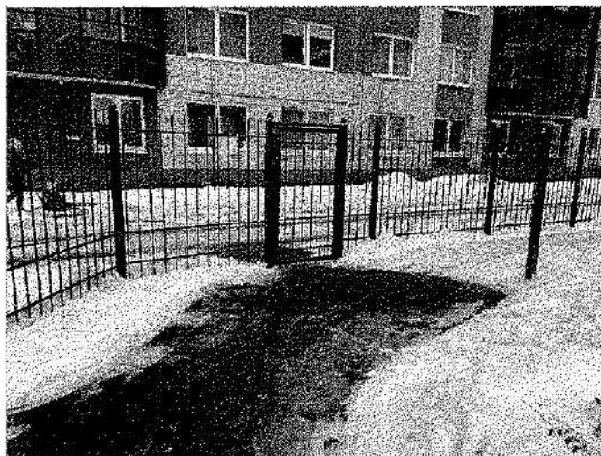
Фото №2 – Вход на прилегающую территорию.
