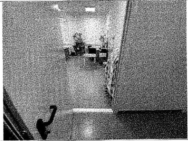
Фото №20 – Пути движения внутри здания (двери).
